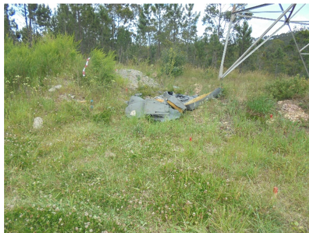
Figura 2 Zona de implantação do poste 23.
