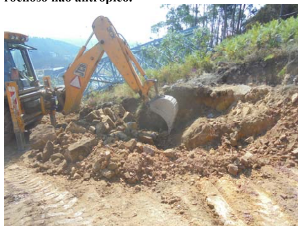
Figura 22 Acompanhamento da abertura de plataforma para implantação de grua no apoio 24.
