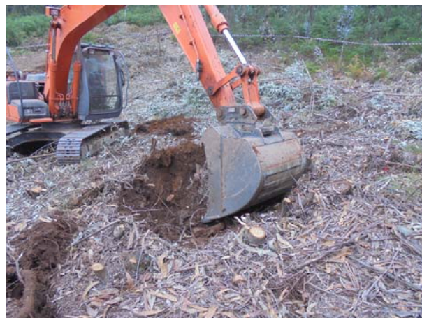
Figura 14 Acompanhamento da escavação do cabouco 2 do apoio 79
