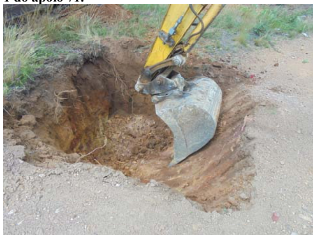
Figura 9 Acompanhamento da escavação do cabouco 2 do apoio 22.
