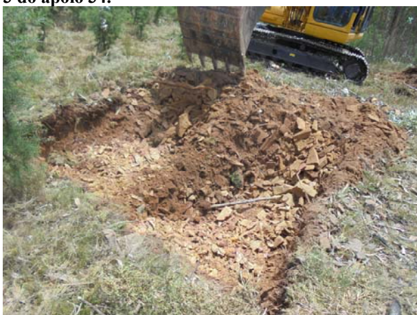
Figura 5 Acompanhamento da escavação no cabouco 2 do apoio 58.
