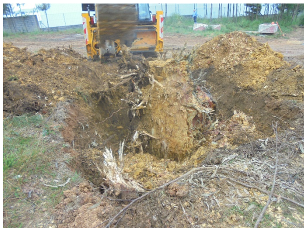
Figura 1 Acompanhamento dos trabalhos de decapagem na área do estaleiro da CME.
