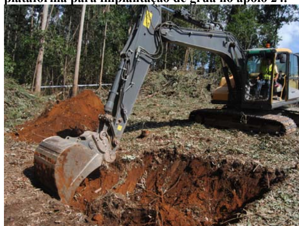
Fotografia 24 Acompanhamento da escavação do cabouco 1 do apoio 98A.
