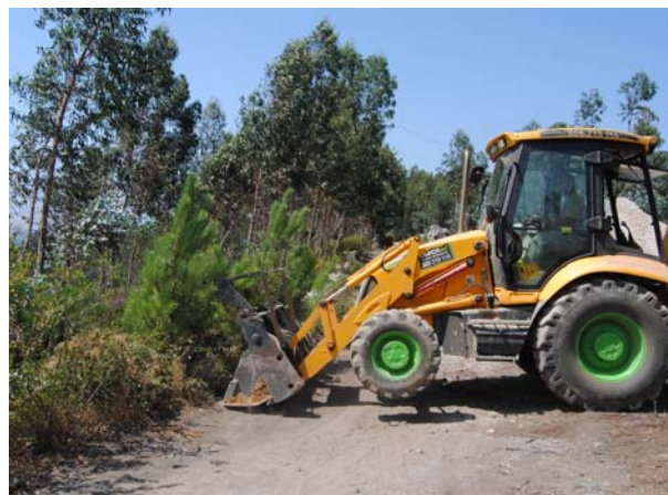
Fotografia 26 Acompanhamento da desmatção do apoio 91.
