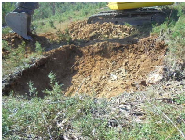
Figura 4 Acompanhamento da escavação no cabouco 2 do apoio 53.
