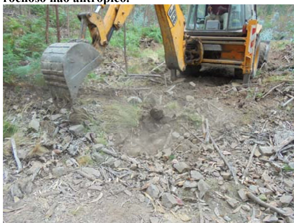
Figura 12 Acompanhamento da desmatção do acesso ao apoio 55.
