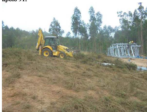
Figura 28 Acompanhamento de desmatção no apoio 92.
