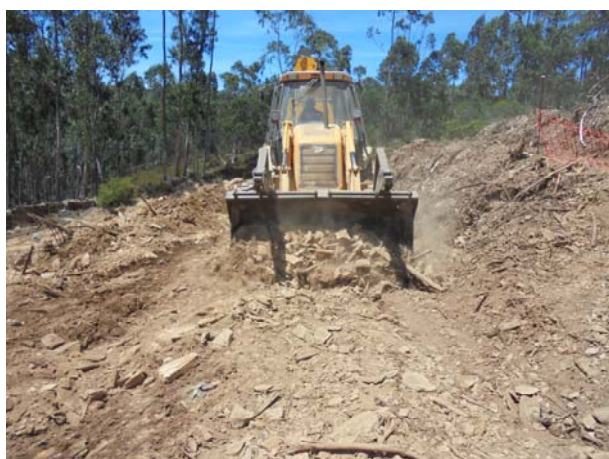
Figura 15 Acompanhamento da abertura de acesso ao apoio 82.
