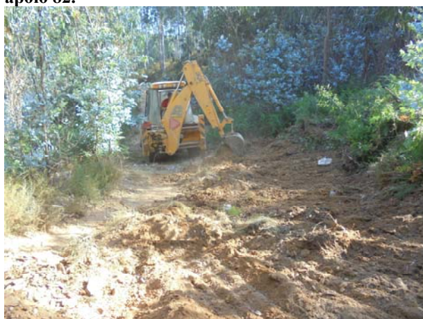
Figura 17 Acompanhamento da abertura do acesso ao apoio 79.
