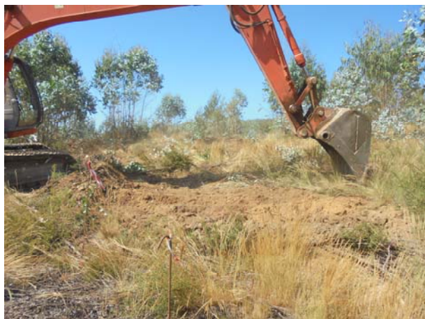
Figura 19 Acompanhamento da abertura do cabouco 2 do apoio 73.
