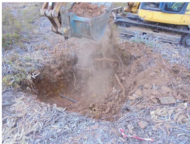
Figura 7 Acompanhamento da escavação do cabouco 1 do apoio 71.
