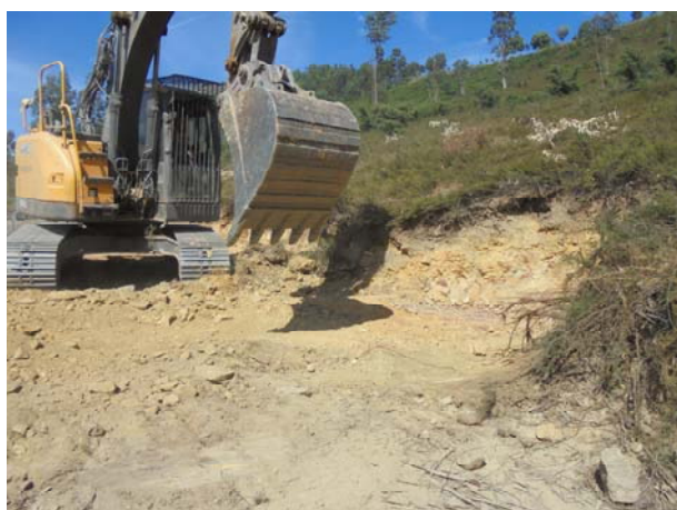
Figura 27 Escavação da plataforma para grua do apoio 93.
