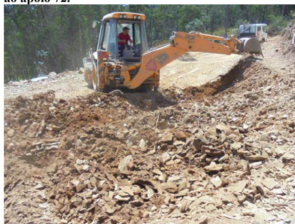
Figura 18 Acompanhamento dos movimentos de terra para a criação de plataforma de grua para o apoio 82.
