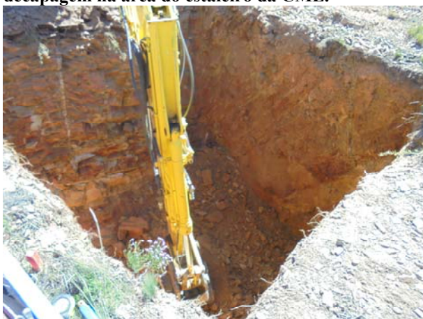
Figura 3 Acompanhamento da escavação no cabouco 3 do apoio 34.
